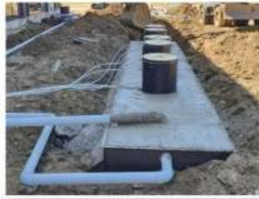
8 콘크리트 타설 마무리
